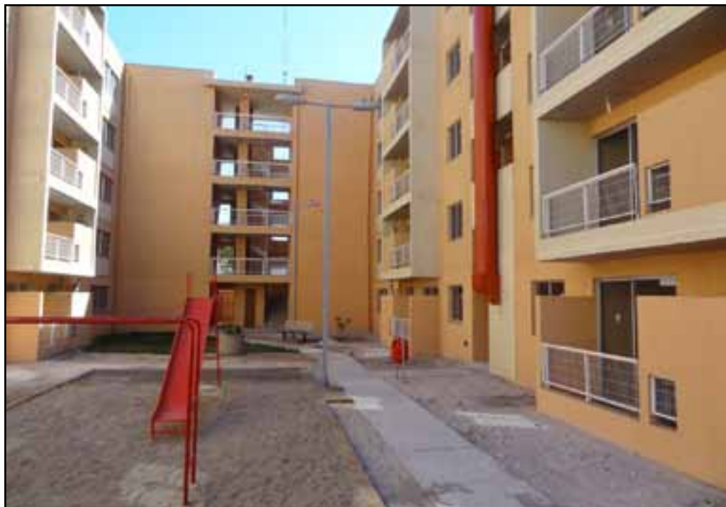
Imagen n°2: Proyecto de vivienda definitiva “EMATI”, gestionado por UTPCH en Estación Central, Santiago. Fuente: UTPCH.
