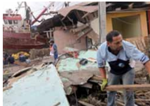
Labores de desescombro.
