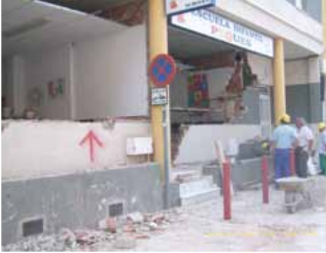
Labores de reconstrucción.
