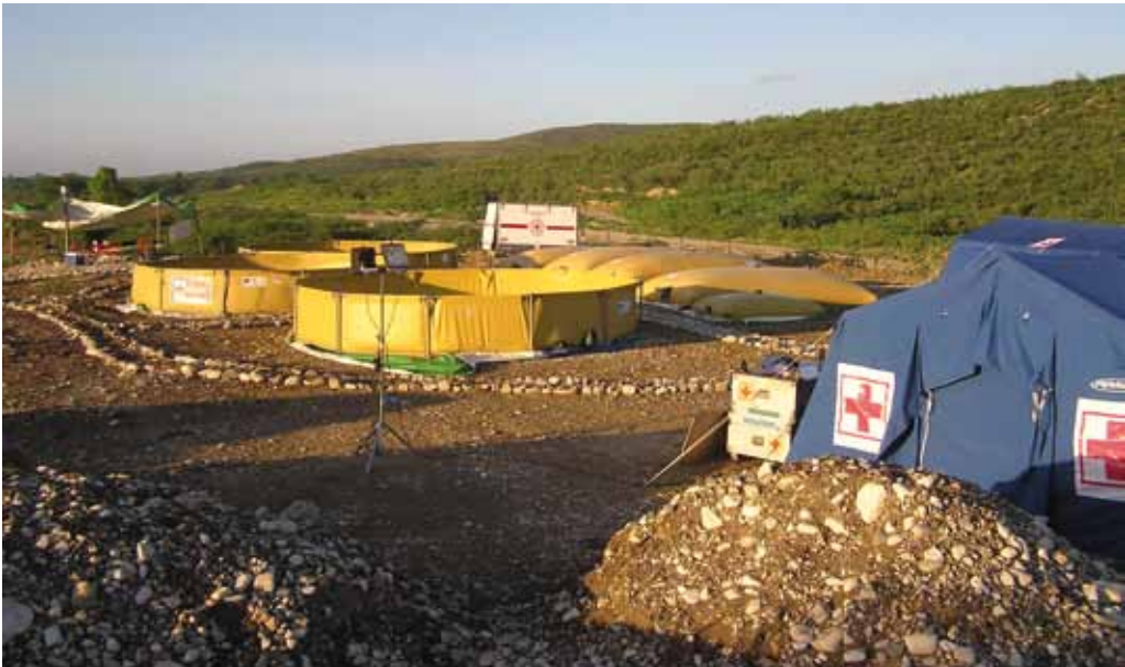
ERU agua y saneamiento desplazada a terremoto de Haití.
